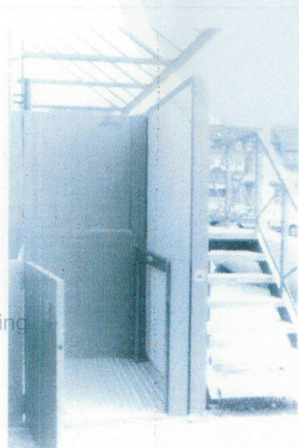
Vareelevator i produktionshal.
